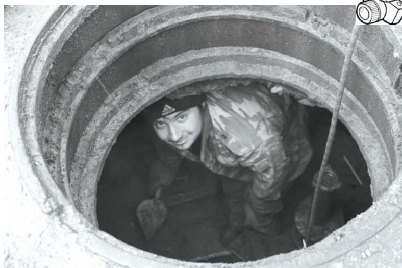
ЛАЗУТЧИК ИЗ «ВОДОКАНАЛА» - им стал на прошлой неделе слесарь аварийно-восстановительных работ Валерий Попов. 15 февраля в водопроводном колодце, расположенном на улице Братьев Шаршановых, потребовалась срочная замена запорной задвижки. Но прежде чем добраться до нее, пришлось выгрести кучу песка. Кстати, в таких условиях слесарям водоснабжающего предприятия приходится работать часто.
