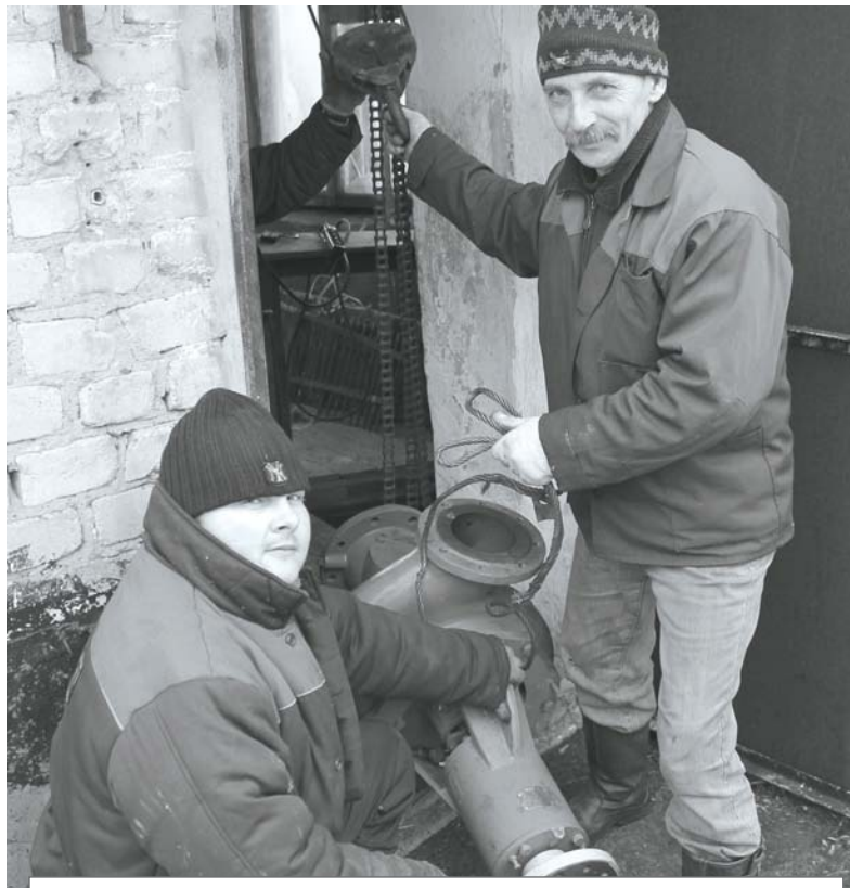
Слесарь-ремонтник очистных сооружений 5-го разряда МУП «Водоканал» А.А. Енко, бригадир слесарей-ремонтников очистных сооружений 5-го разряда Н.М. Белоусов
